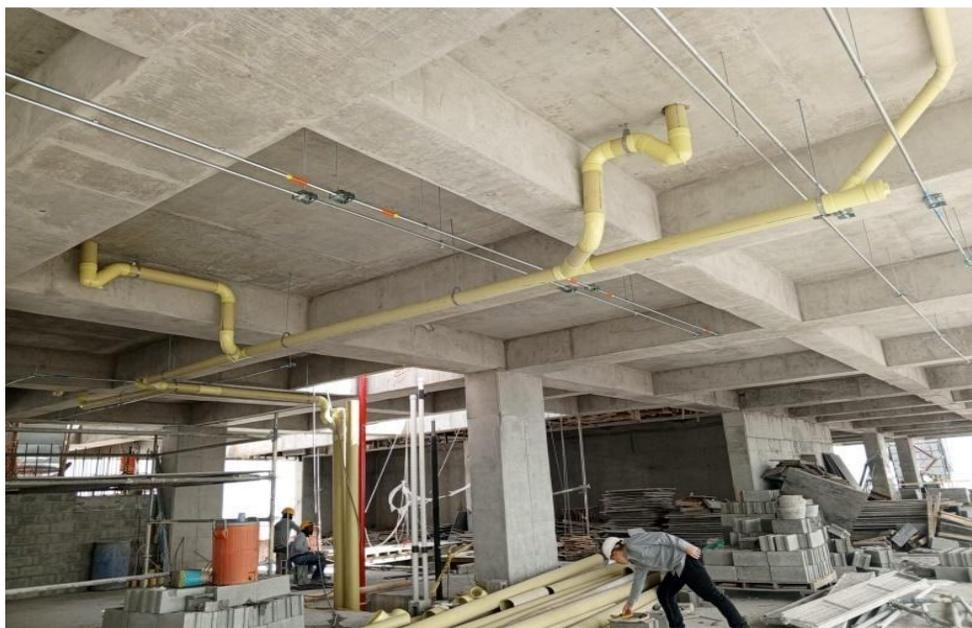
*Fuente: Infravalle, diciembre 2024. Instalación de red interna sanitaria piso 14.*
