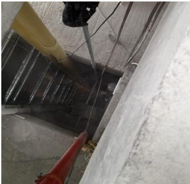
*Fuente: Infravalle, diciembre 2024. Instalación de red interna de gas hacia la caldera en piso 15.*
