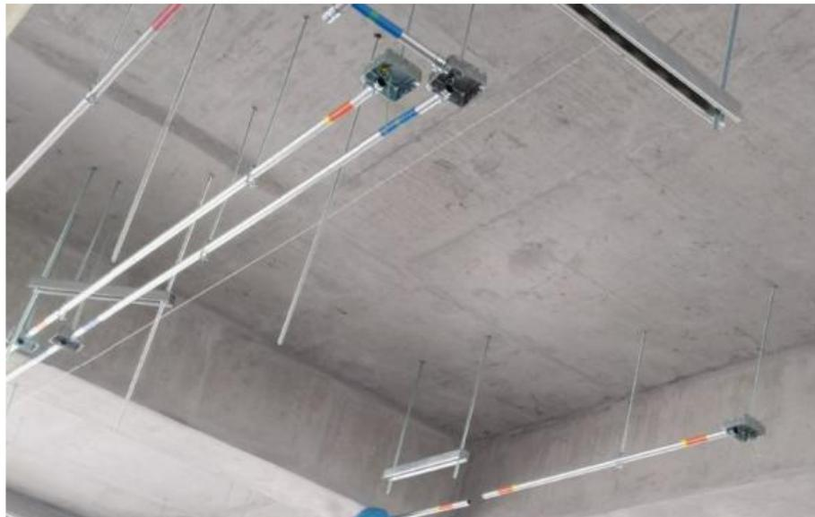
*Fuente: Informe de Avance de Obra No. 19 diciembre 2024. Ejecución de Infraestructura de baja tensión (bandejas y tuberías)*
