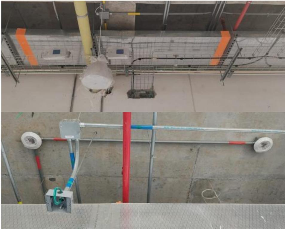
*Fuente: Informe de Avance de Obra No. 19 diciembre 2024. Ejecución de elementos de Seguridad, voz y datos y Elementos de detección de incendios (sensores, estaciones, estrobos)*
