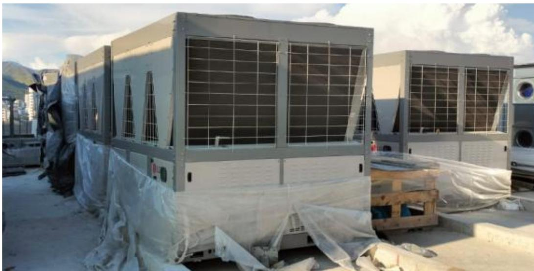
*Fuente: Infravalle, diciembre 2024. Instalación de enfriadores y bombas de agua en cubierta piso 15*
